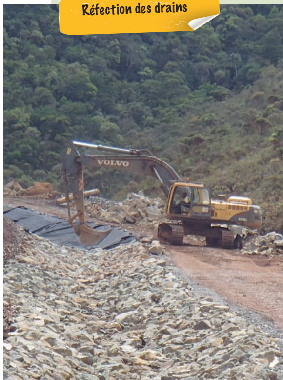
Réfection des drains
